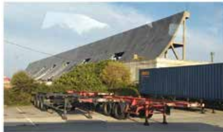
Şekil-5. Le Havre Limanı'nın Rüzgâr Duvarları
